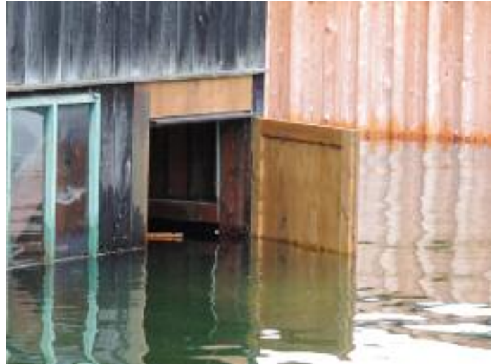
Eingang in die Bootshütte
